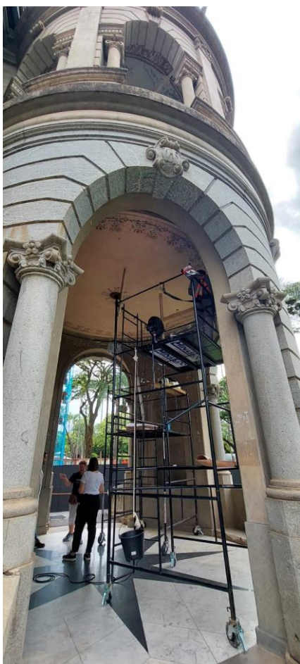
Intervenções no torreão Autoria: Maria Letícia Ticle Data: 11/12/2023
