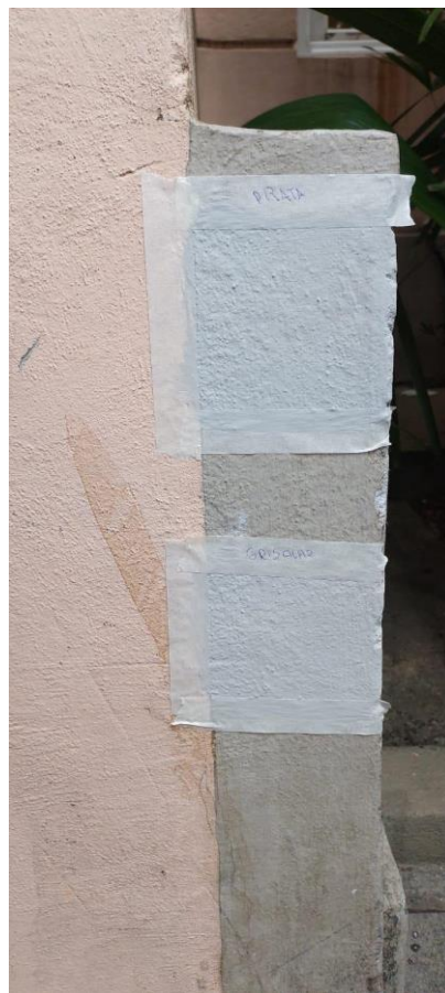
Teste de cores em alvenaria externa Autoria: Maria Letícia Ticle Data: 11/12/2023
