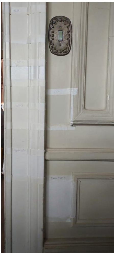
Teste de cor em alvenaria interna e esquadria de madeira Autoria: Maria Letícia Ticle Data: 11/12/2023
