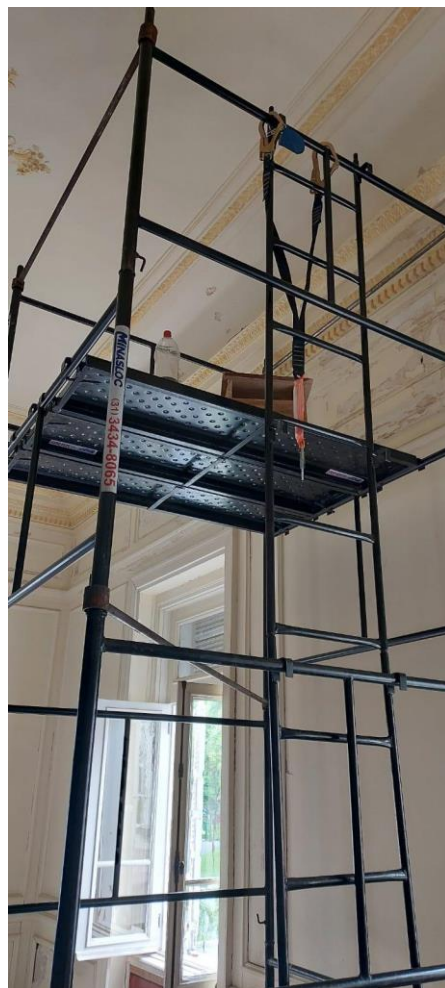
Andaime montado no Quarto da Rainha Autoria: Francielle Ferreira Data: 11/12/2023
